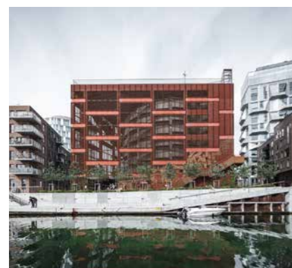
Tijdelijk parkeergebouw (demontabel) bij de entree
