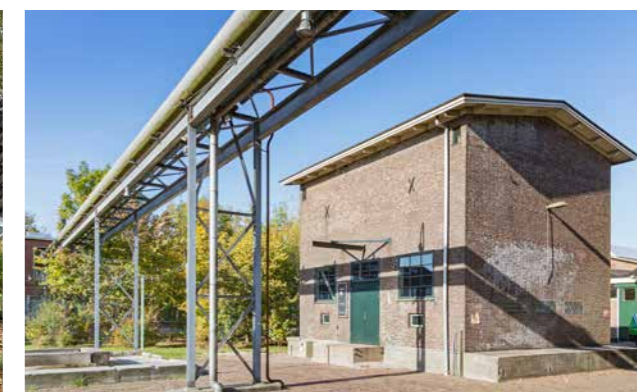
Voormalige collectieve energiesysteem
