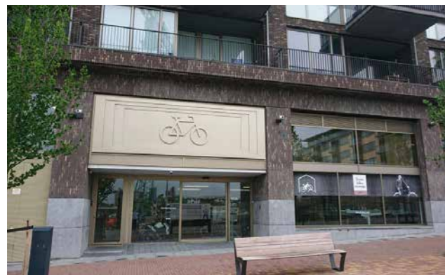
Inpandige gemeenschappelijke fietsenstallingen
