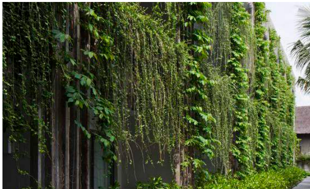
Groene gevel parkeervoorziening
