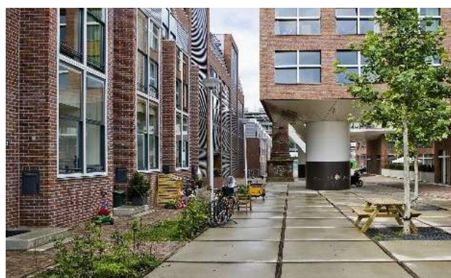
Smalle privé-buitenruimte aan het plein
