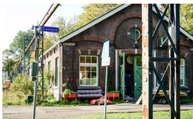
Bestaande overgang 'niet te aangeharkt' privé – openbaar op Hembrug
