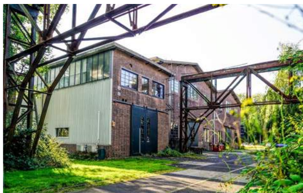
Parkeervoorziening in rijksmonument Gebouw 320
