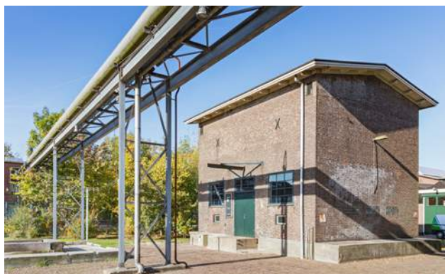
Voormalige collectieve energiesysteem
